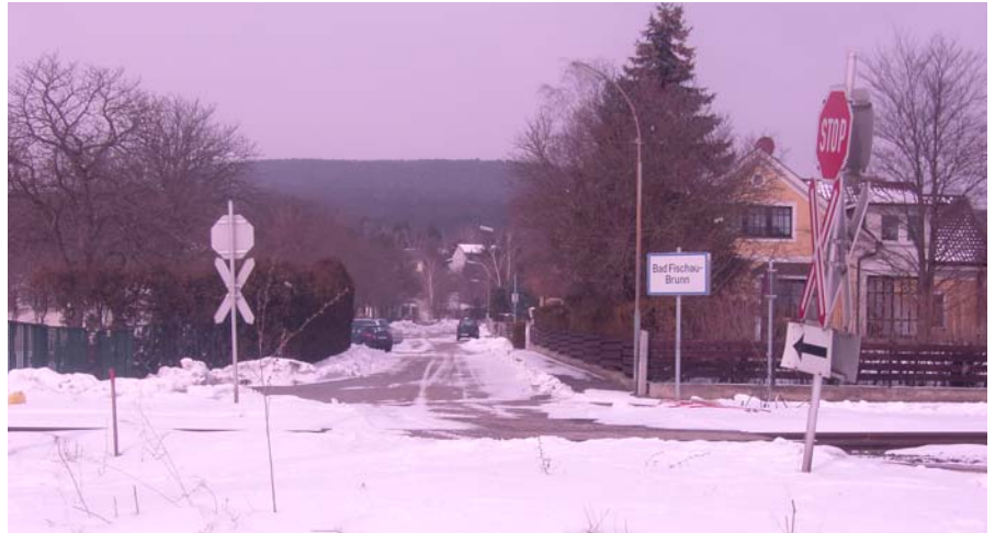
Auch der Bahnübergang Am Saatzen wird durch eine Signalanlage gesichert
