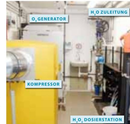
Abbildung 2: Innenansicht des Anlagencontainers mit Kompressor und H<sub>2</sub>O<sub>2</sub>-Dosierstation im Vordergrund.
